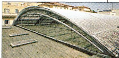
La copertura della serra, che contiene il ristorante e il bar, è una volta a botte di acciaio e vetro che richiama quella del progetto di Piacentini del 1883. Il sole è filtrato da una sorta di incannucciata metallica che trattiene il calore
