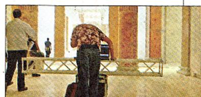
La ristrutturazione delle sale, qui sopra quella centrale, ha previsto il restauro delle colonne e degli stucchi. L'impiego di nuove luci e controfoderature delle pareti per contenere gli impianti ed evitare di rovinare i muri
